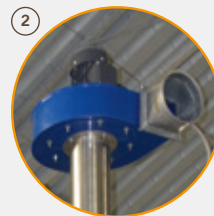
CO 2 EXTRACTION FAN
