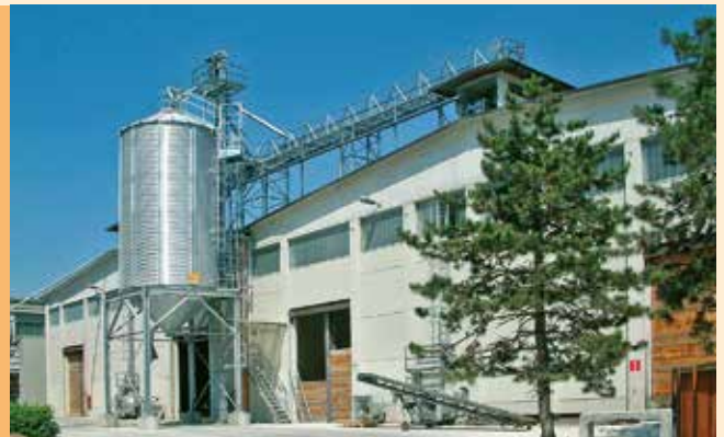
■ Fast load silos.
